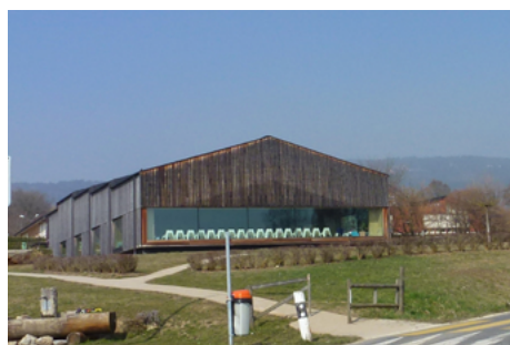
La piscine de Bassins
